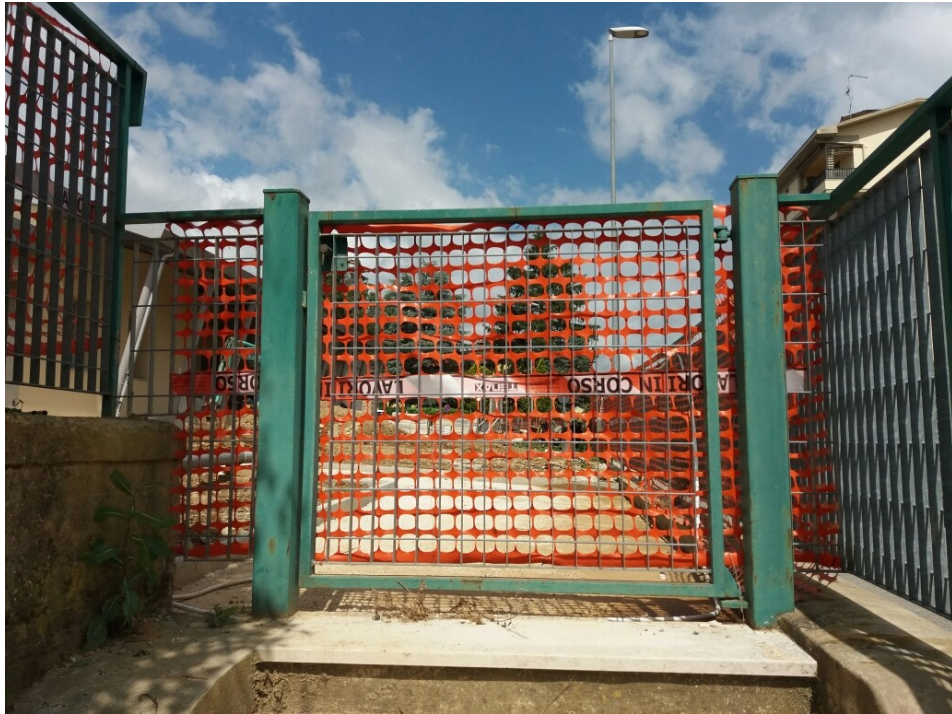
FIG. 5 - Particolare cancello pedonale esistente
