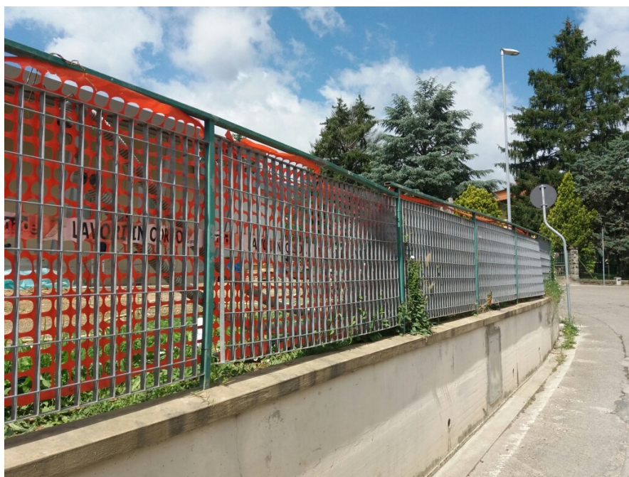
FIG.2 - Particolare della recinzione esistente sul lato Nod-Est
