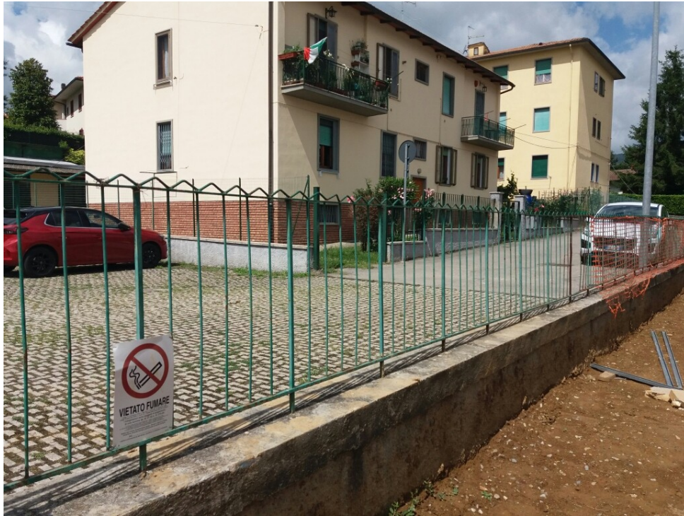
FIG.3 - Particolare della recinzione esistente sul lato Sud-Ovest
