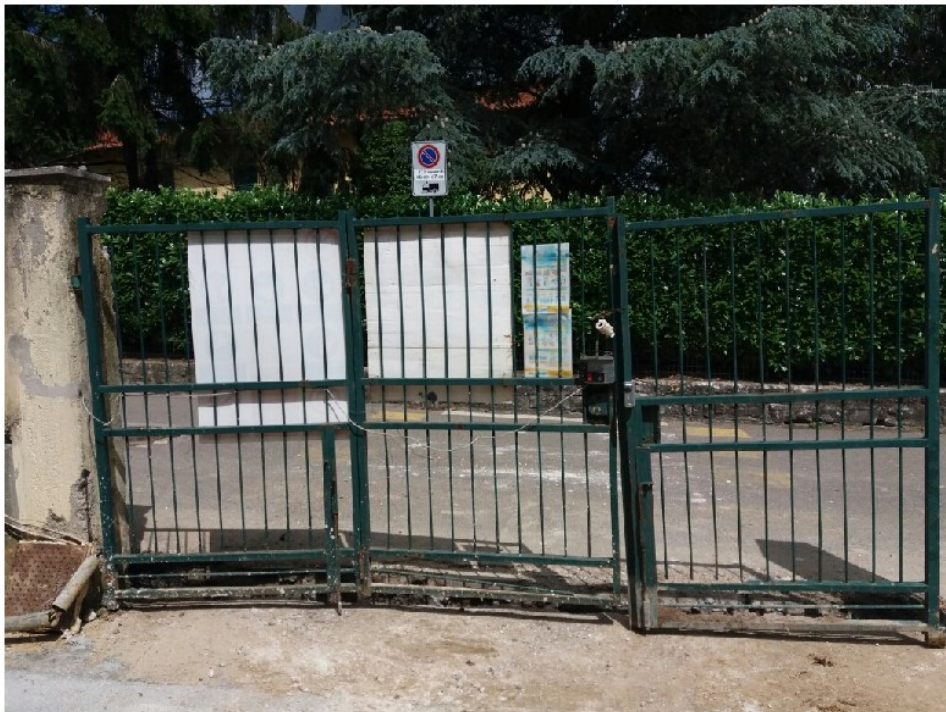
FIG. 6 - Particolare cancello pedonale esistente
